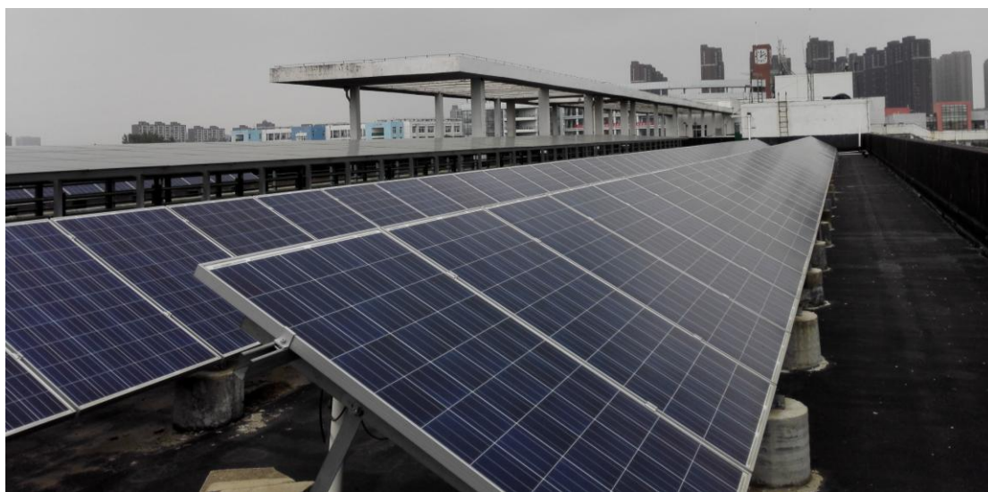
图12 33KW分布式光伏电站建成图
